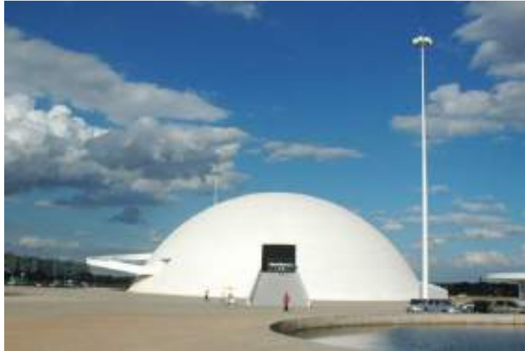
Figura 8 – Fachada do prédio do MUN
