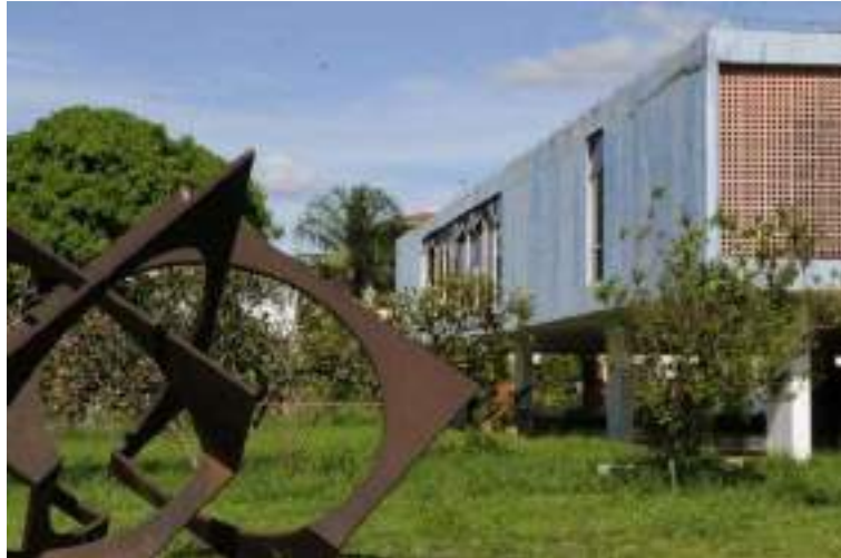
Figura 12 – Prédio do MAB abandonado
