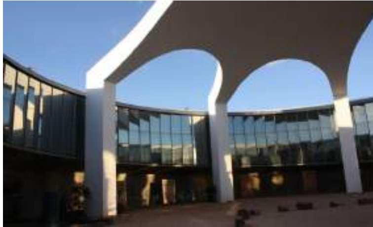
Figura 6 – Interior do prédio do MPI
